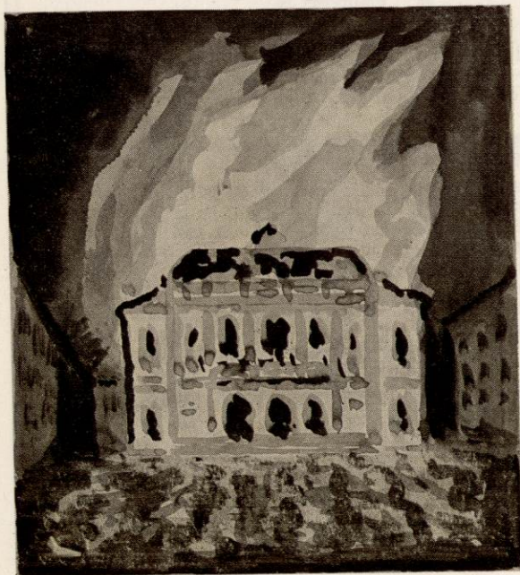
LE FEU AVAIT PRIS NAISSANCE DANS LE POSTE DES POMPIERS
