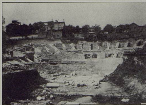
Le théâtre en cours de restauration en 1940.
